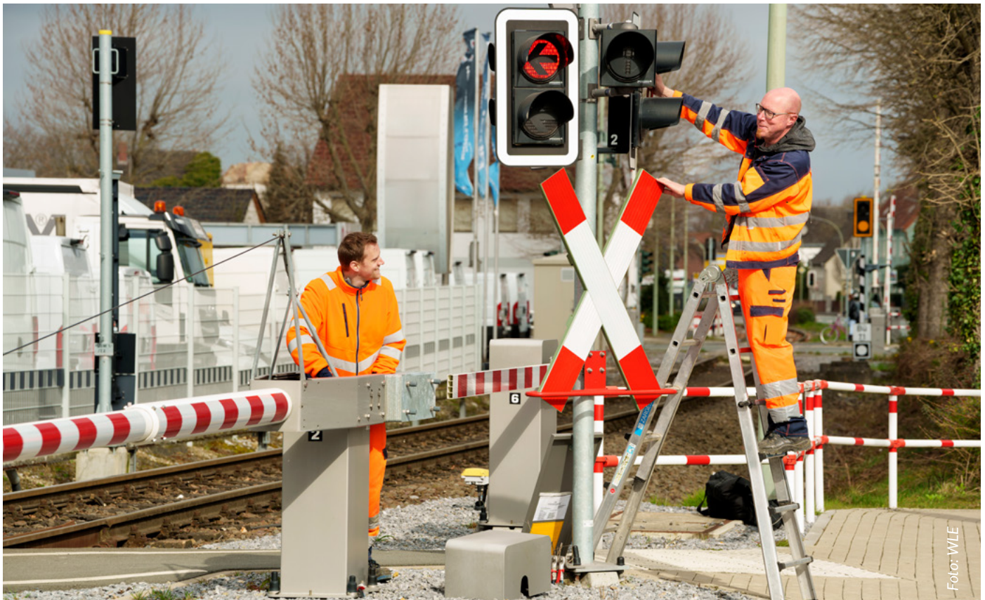
Wartungsarbeiten an der Signalanlage
