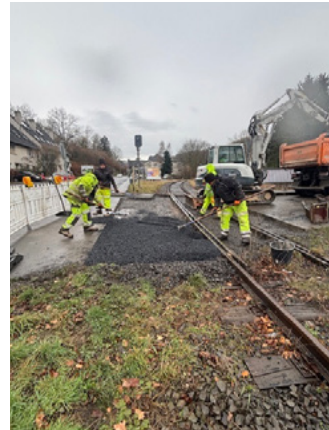
Arbeiten am Bahnübergang „Röhrbrücke“ in Müschede, Foto: RLG
