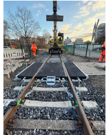
Baumaßnahme am Bahnübergang „Alter Papenweg“ in Hamm, Foto: RLG
